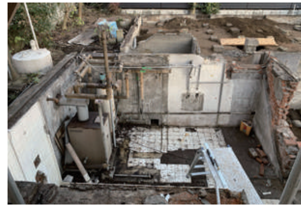
地下1階の解体中に発見されたレンガ基礎
