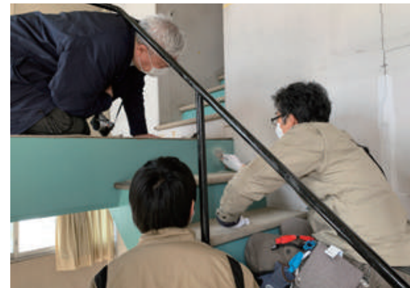
階段色彩のこすり出し調査
