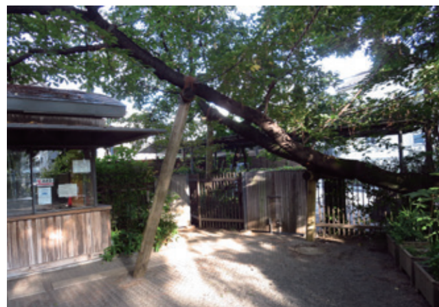
▲カンザクラ「大寒桜」支柱設置状況
