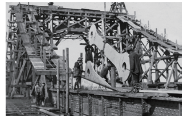
清洲橋のチェーン架設状況
