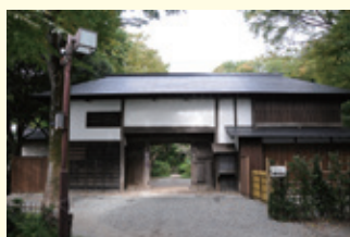
日本多家住宅長屋門
