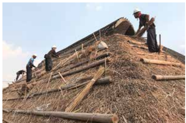
板橋区 旧粕谷家住宅 屋根葺き替え工事
