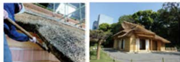
茅葺の仕上げ作業の様子
