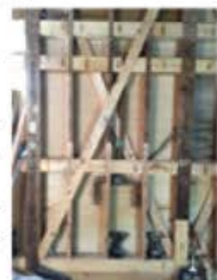
筋違いや構造用合板を使っての耐震補強
