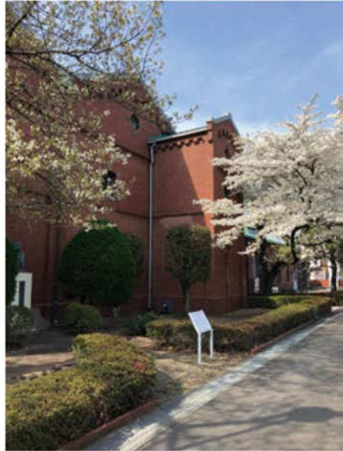
＜旧醸造試験所第一工場＞
