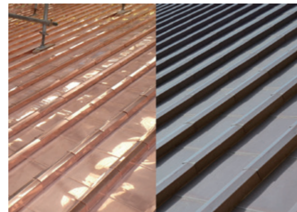
銅板葺屋根 左：施工直後 右：現在
