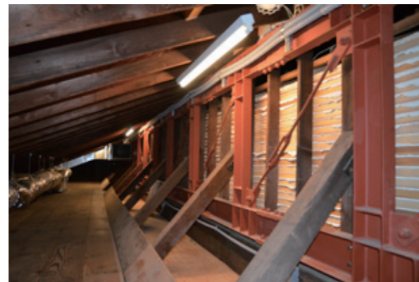
鉄骨トラスによる補強
