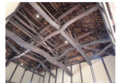
土間の梁組み
