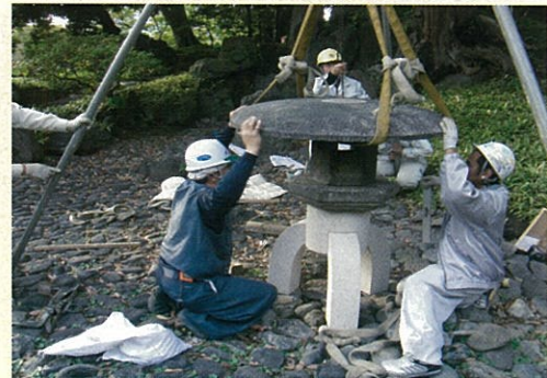
文化財庭園石造物補修工事「蓬莱島」
