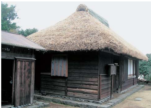
茅葺き屋根補修後の母屋
