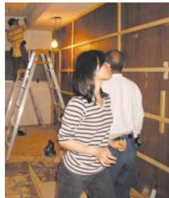
改装中の様子。天井が終わり壁にとりかかる
