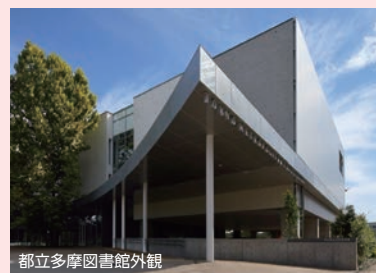
都立多摩図書館外観
