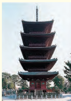
本門寺五重塔 写真提供：(公財)文化財建造物保存技術協会
