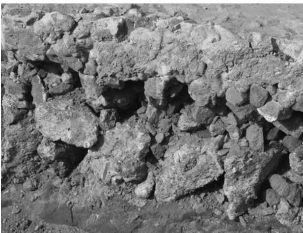
第3図 関東大震災後に転用した煉瓦地業層
