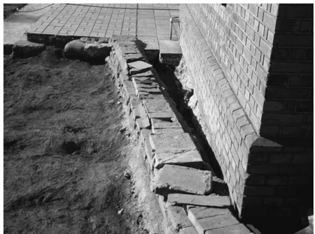
第4図 スレート瓦の再利用状況
