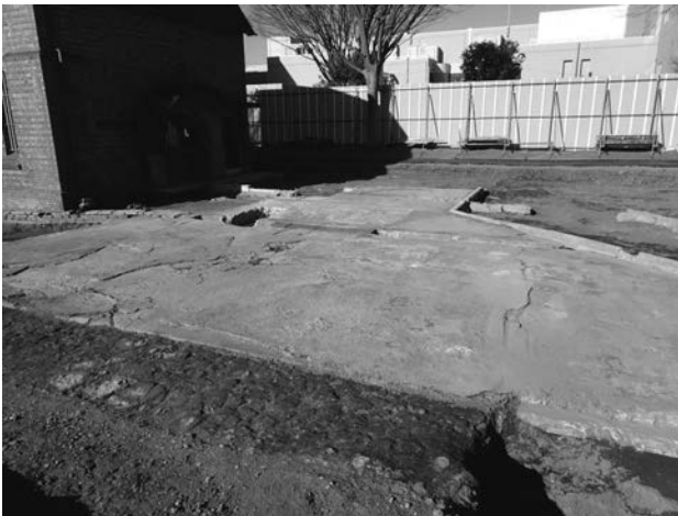
第5図 コンクリート塀を倒した路盤
