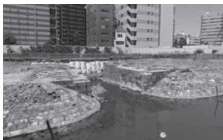
港区 高輪築堤跡 第7橋梁橋台部
