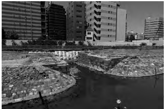
第5図 第7橋梁橋台部
